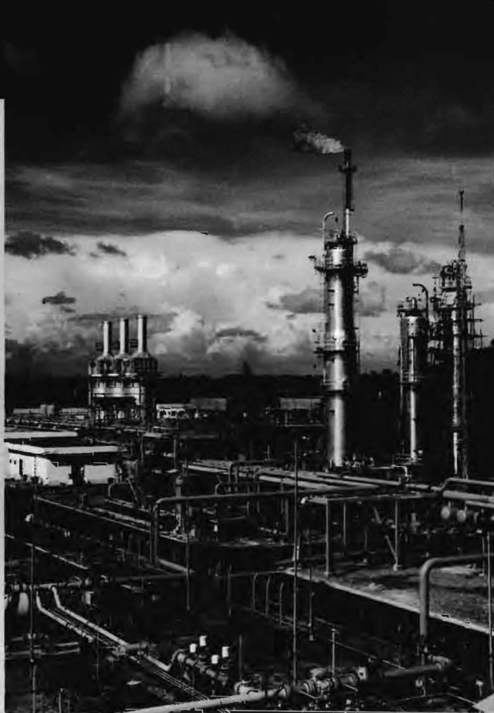
Nhà máy xử lý khí Dinh Cố - Bà Rịa
