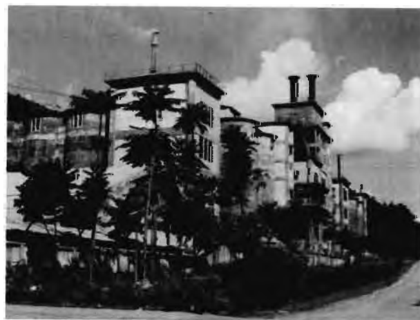
Toàn cảnh nhà máy Xi măng
