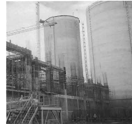
Nhà máy xi măng Nghi Sơn Nghi Son Cement Factory
