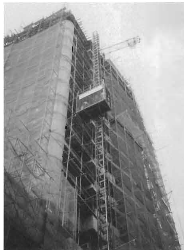
Hệ thống giáo Minh Khai tại công trình TT Thương mại Đại Hà Minh Khai scaffolds system at DAEHA Business Center
