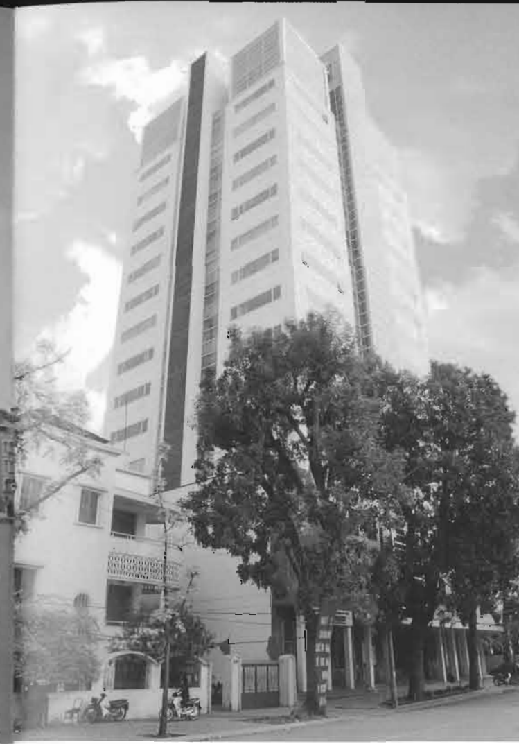
Tòa nhà đệ nhất trung tâm Prime Center Building
