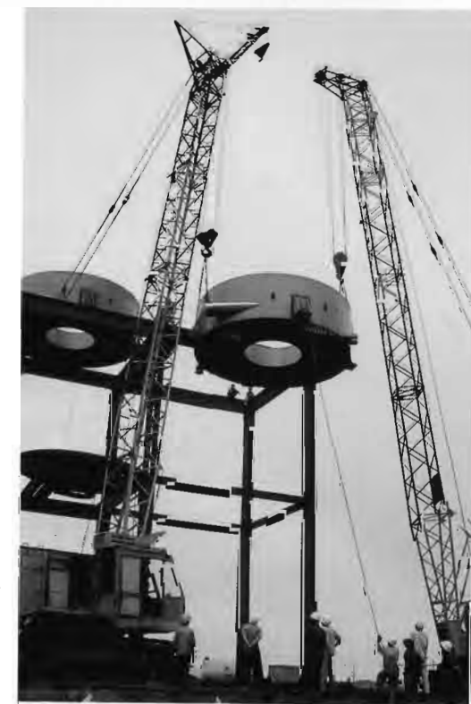
Lilama có các phương tiện vận tải tiên tiến: cầu 500 tấn, đầu kéo, tàu thủy tải trọng lớn. LILAMA has advanced transport facilities including cranes of 500 tons, tractors, large ships
