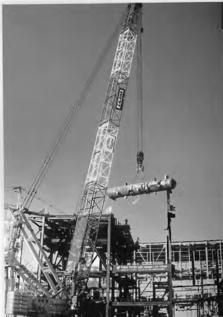
Xe cẩu 500 tấn lắp bao hơi nhà máy nhiệt điện Phú Mỹ 1 Crawler crane of 500 tons for installing steam drum of Phu My 1 thermal power plant
