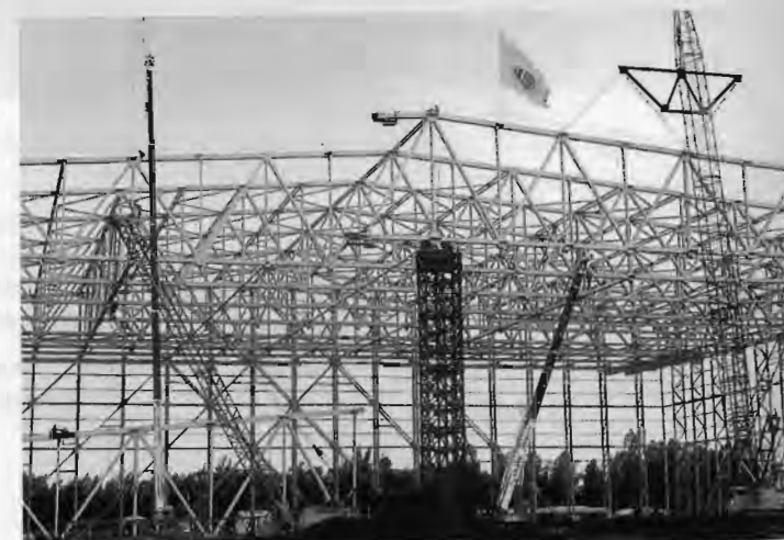
Chế tạo và lắp Hangar máy bay thân lớn A76 Nội Bài, khẩu độ 186m Manufacturing and installing works of the Noi Bai International Airport Hangar A76 Project, span 186m
