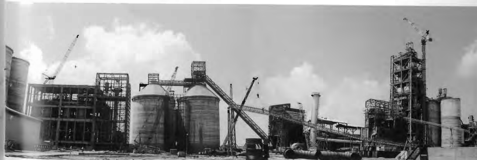
Lắp đặt các nhà máy xi măng công suất 1,4 - 2,3 triệu tấn/năm. Erecting cement plants of annual output of 1.4 - 2.3 million tons
