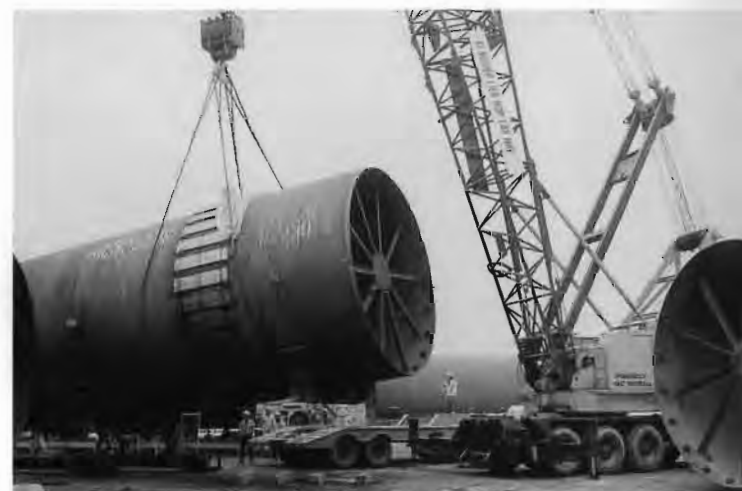
Vận chuyển vào vị trí và lắp đặt thiết bị siêu nặng các nhà máy: xi măng, nhiệt điện, thủy điện... Lifting and installing super heavy equipment for cement plants, hydro and thermal power plants.
