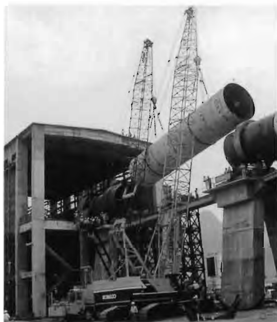
Vận chuyển vào vị trí và lắp đặt thiết bị siêu nặng các nhà máy: xi măng, nhiệt điện, thủy điện... Lifting and installing super heavy equipment for cement plants, hydro and thermal power plants.
