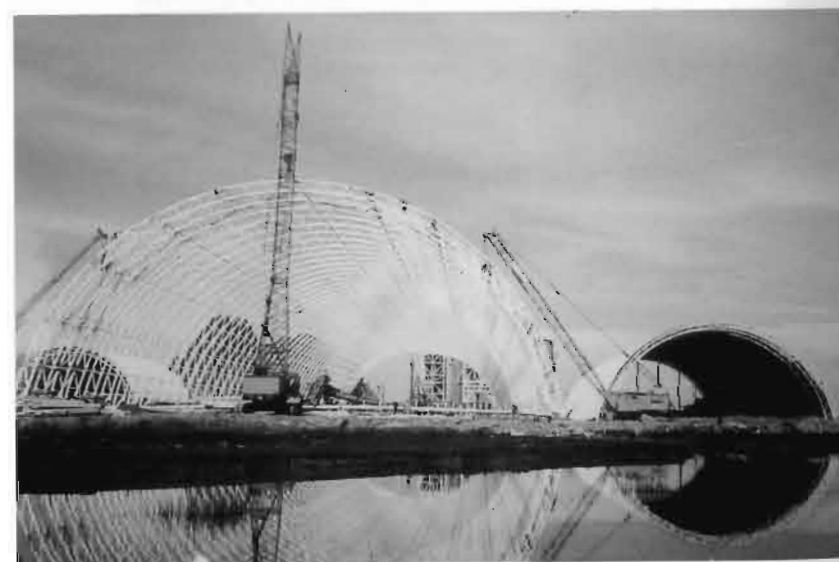
Xây dựng, nén ép cọc móng lắp dựng kết cấu thép các công trình công nghiệp và dân dụng. Constructing, pressing foundation piles installing steel structures for industrial and civil projects.
