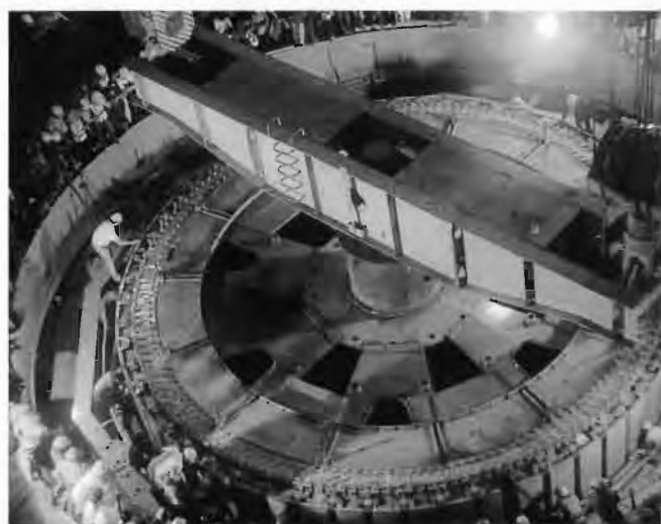
Lắp thiết bị toàn bộ các nhà máy nhiệt điện, thủy điện Erecting all equipment for thermal and hydro power plants
