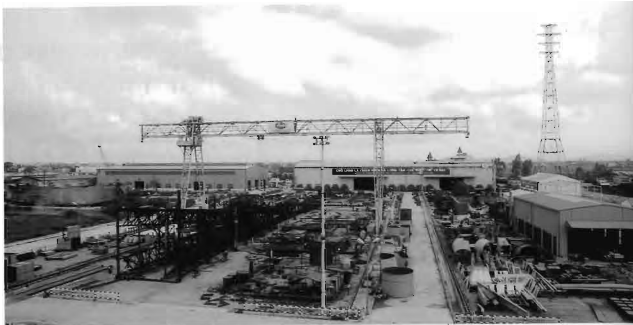
Nhà máy Chế tạo thiết bị và đóng tàu Hải Phòng. Hai Phong Equipment Manufacturing and Ship Building Co.
