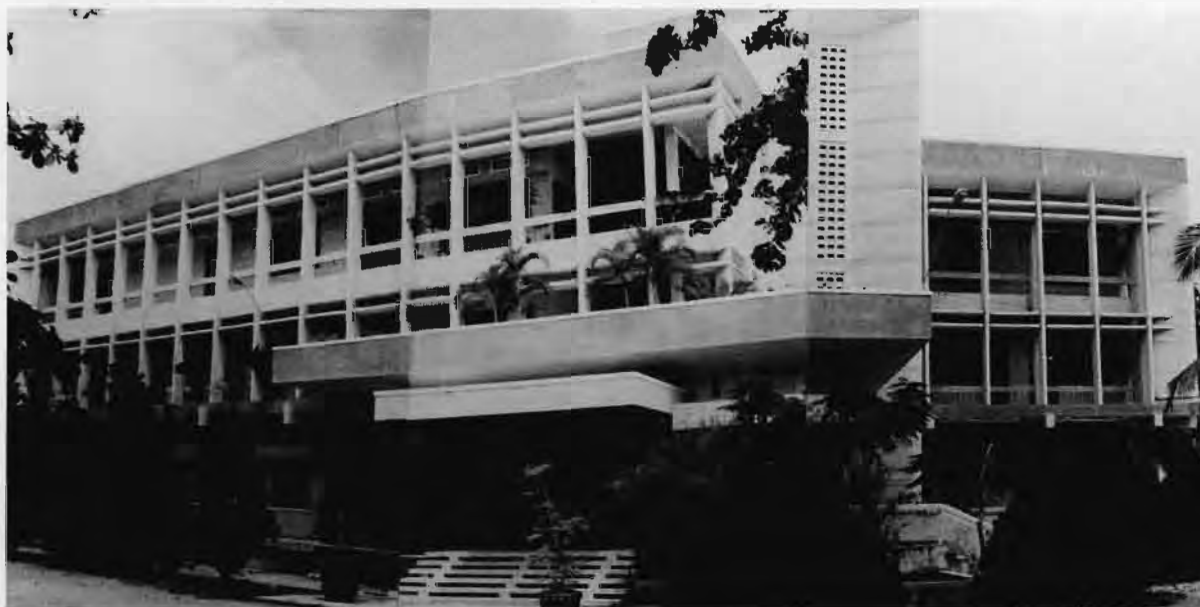
Trụ sở chính của Trung tâm tại Nha Trang Headquarters of RIA3 in Nha Trang
