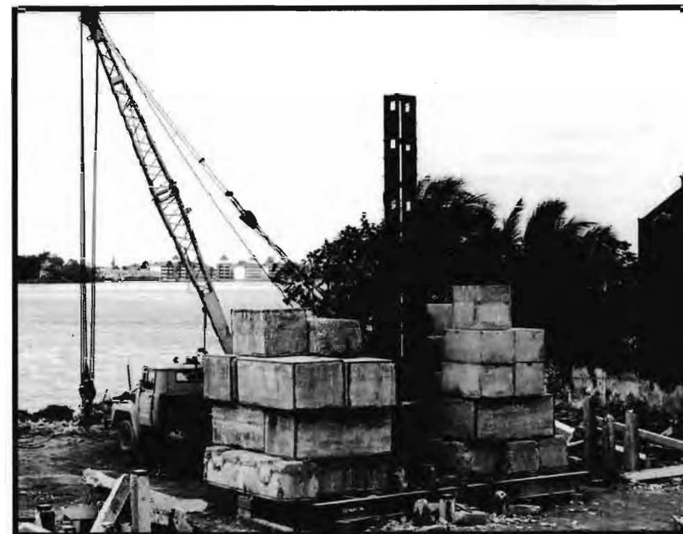
Pile Load Test, Giang Vo Hotel, Hanoi Thí nghiệm tải trọng cọc, Khách sạn Giảng Võ, Hà Nội
