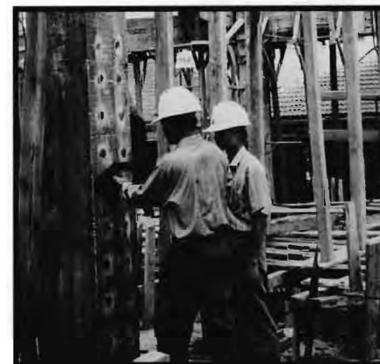
Windsor Probe Concrete Testing Bắn súng thử bê tông
