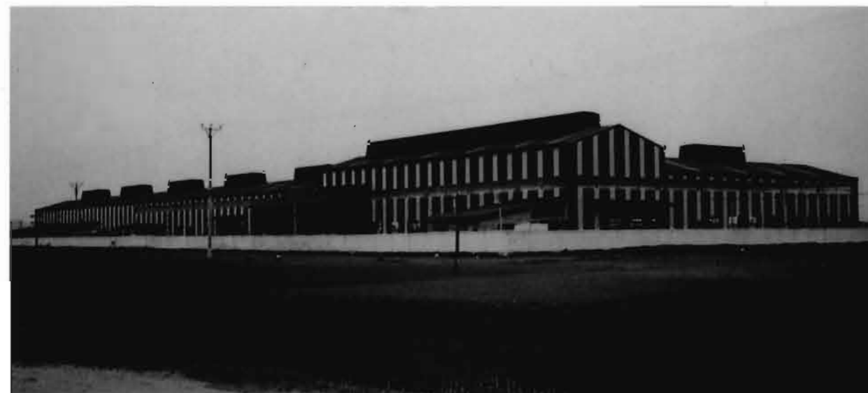
Công ty ống thép Việt Nam Tp Hải Phòng – Vietnam Pipe Corporation Haiphong City
