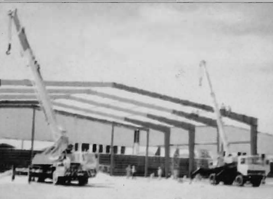
Lắp ráp nhà xưởng máy bay khẩu độ 48m
