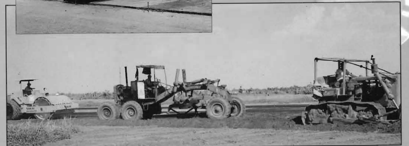
Thi công nền đất sân bay
