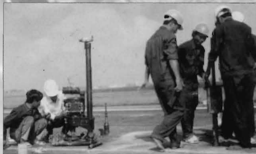
Khoan mẫu, kiểm định chất lượng công trình sân bay DRILLING TO EVALUATE AN AIRPORT CONSTRUCTION QUALITY
