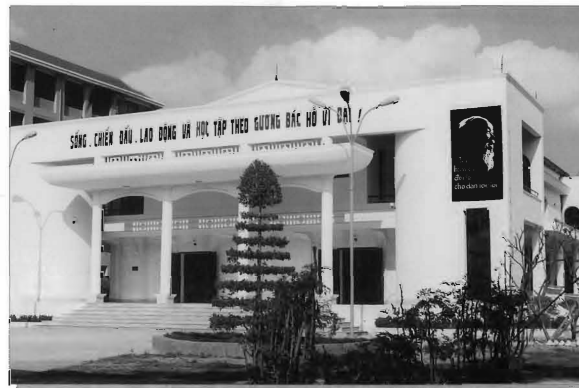
Những công trình chất lượng cao THE HIGH QUALITY CONSTRUCTION
