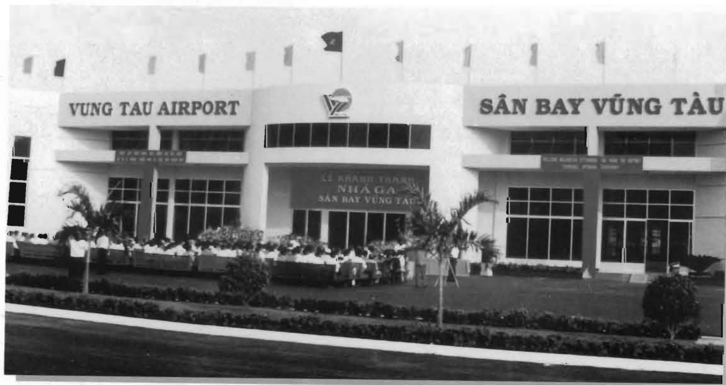
Nhà ga sân bay Vũng Tàu VUNGTAU AIRPORT TERMINAL
