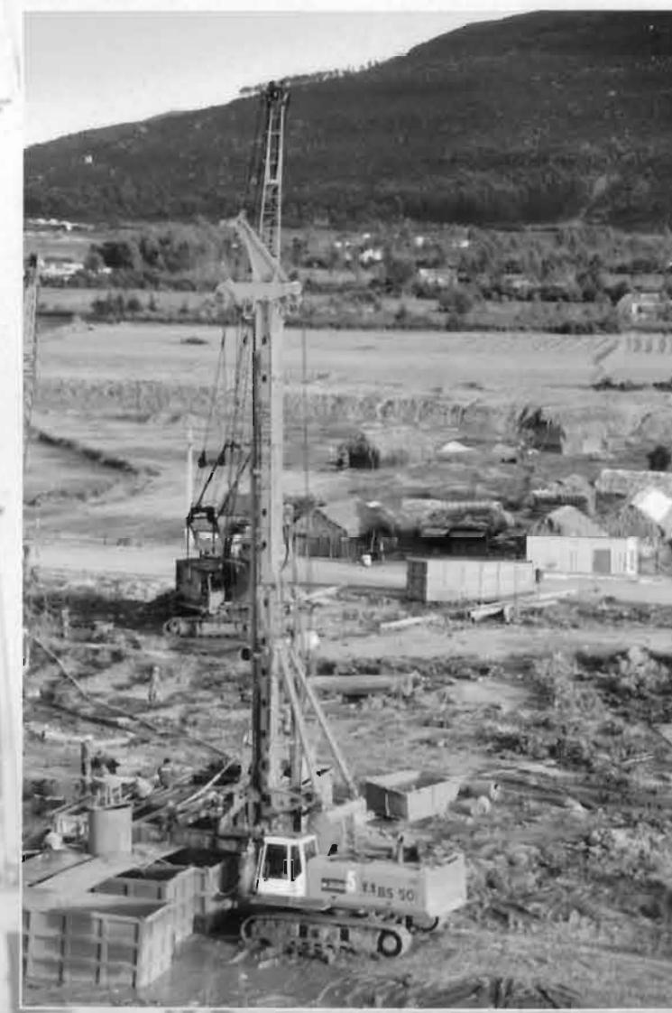
Khoan cọc nhồi. Bored piling work.
