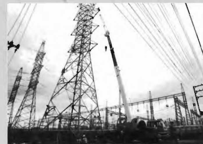
Lắp dựng cột đường dây 220KV Phú Mỹ - Nhà Bè - Phú Lâm. Erection of Tower Phú Mỹ - Nhà Bè - Phú Lâm 220KV transmission line
