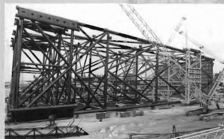
Lắp ráp chân đế giàn khoan dầu khí - Vũng Tàu. Erection of oil platform in Vũng Tàu.
