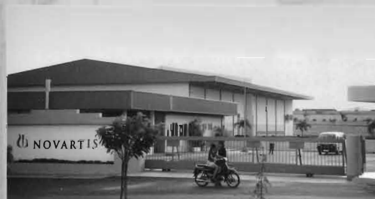
Nhà máy NOVARTIS - Khu Công nghiệp Biên Hòa II. NOVARTIS Factory in Bien Hoa II Industrial Zone.
