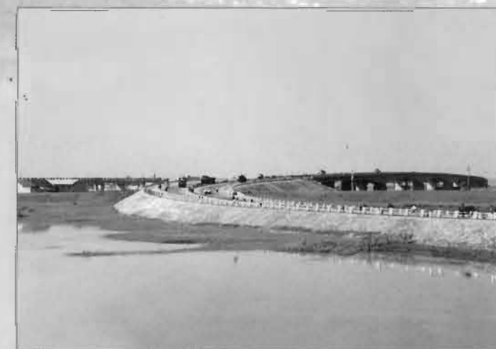
Cầu Phú Lương. Phu Luong Bridge.
