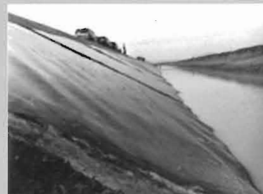
Chống thấm kênh Phú Ninh. Water proofing for Phu Ninh canal.
