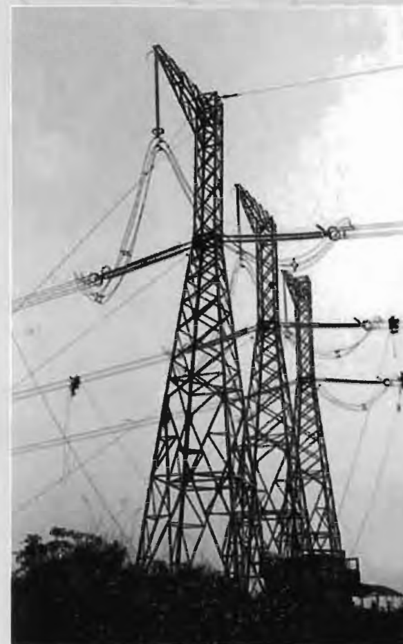
Lắp đặt khung định vị đường dây 500KV Bắc - Nam. Installation of spacers North - South 500KV transmission line.
