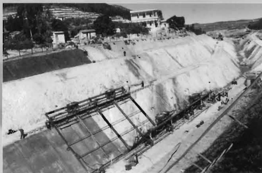
Thi công kênh thải hồ Nhà máy Nhiệt điện Phá Lại II Construction of a canal at Pha Lai power plant.
