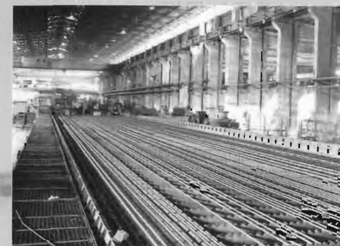
Nhà máy cán thép Gia Sàng - Thái Nguyên. Gia Sang Steel rolling Plant in Thai Nguyen.
