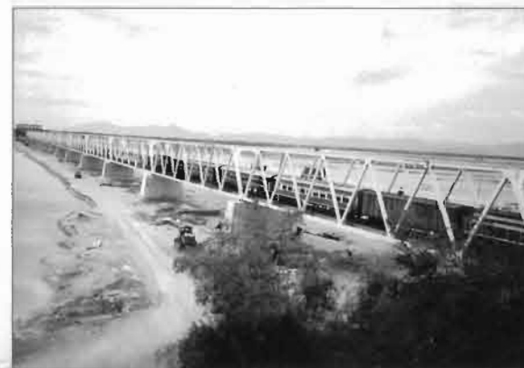
Cầu Đà Nẵng. Da Rang Bridge.
