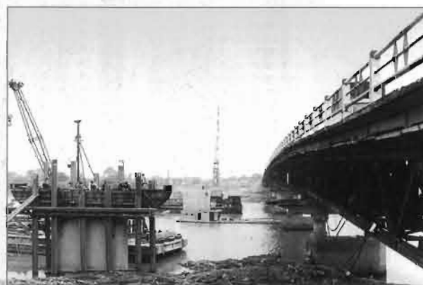
Cầu Sông Mã mới thay cầu Hàm Rồng. The new Song Ma Bridge.
