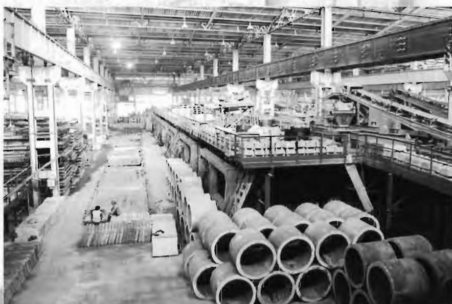
Sản xuất bê tông định hình sẵn tại Nhà máy bê tông Xuân Mai. Prefabricated concrete Factory Xuan Mai.
