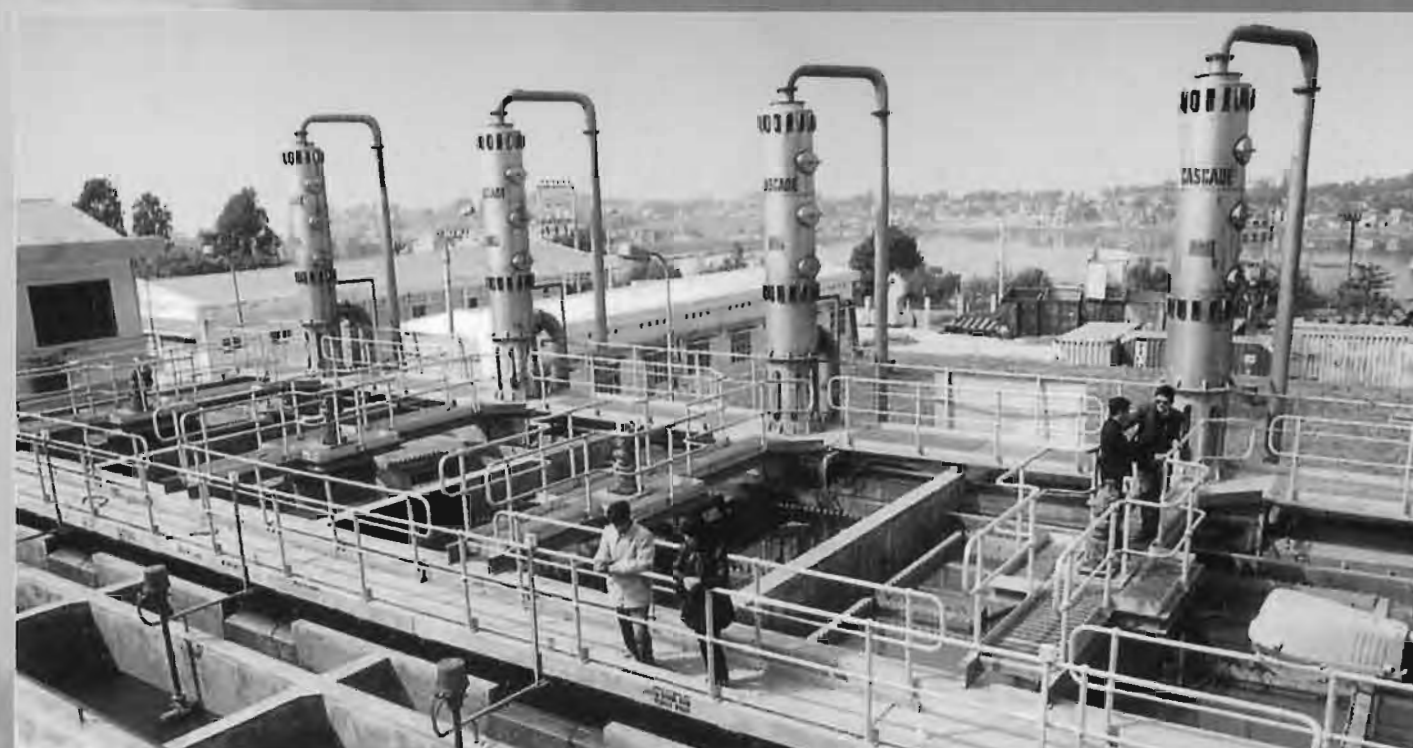
Nhà máy nước Bắc Ninh. The Bac Ninh water plant.
