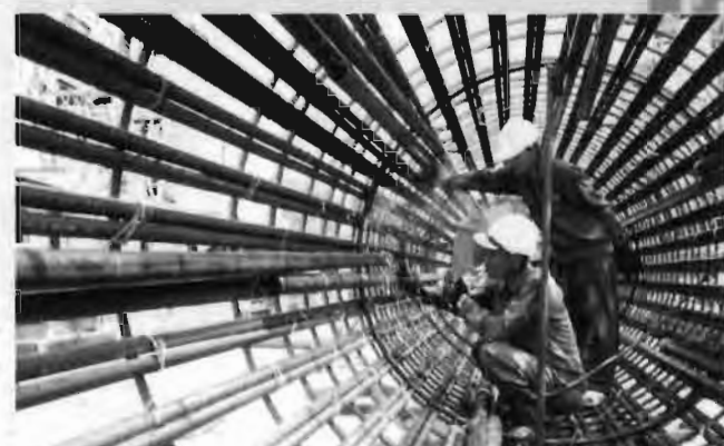
Hàn cốt thép cọc nhồi. Steel reinforcement of a bored pile.
