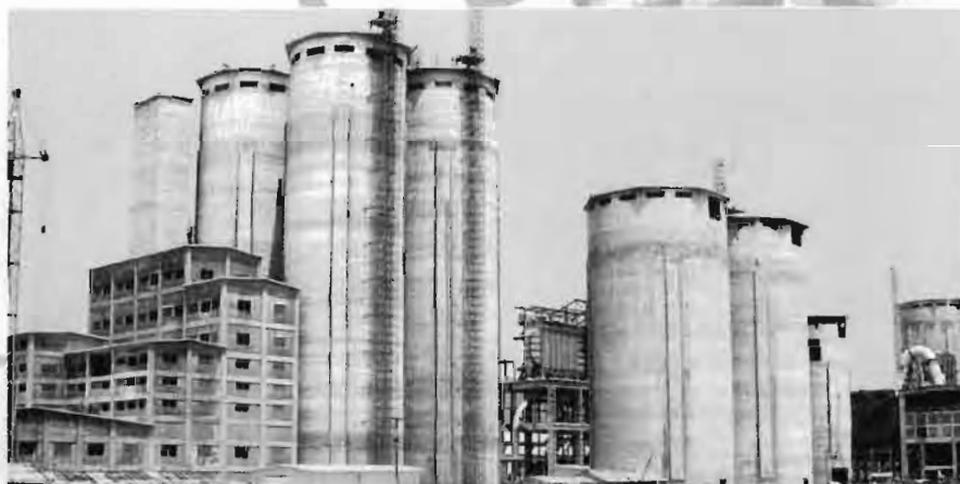
Hệ thống Silo được thi công theo Công nghệ mới. Silos of the But Son Cement Plant.
