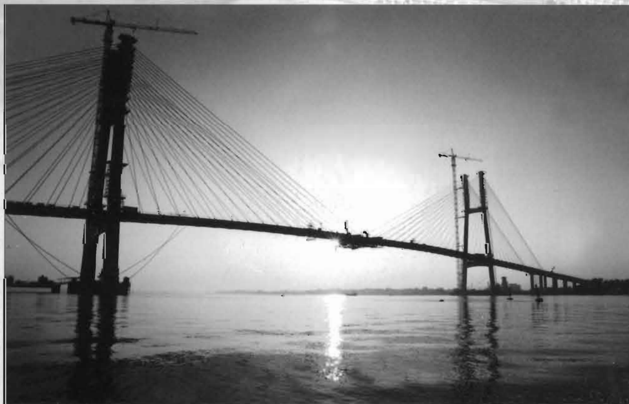
Cầu dây văng Bắc Mỹ Thuận. Bac My Thuan Bridge under construction.
