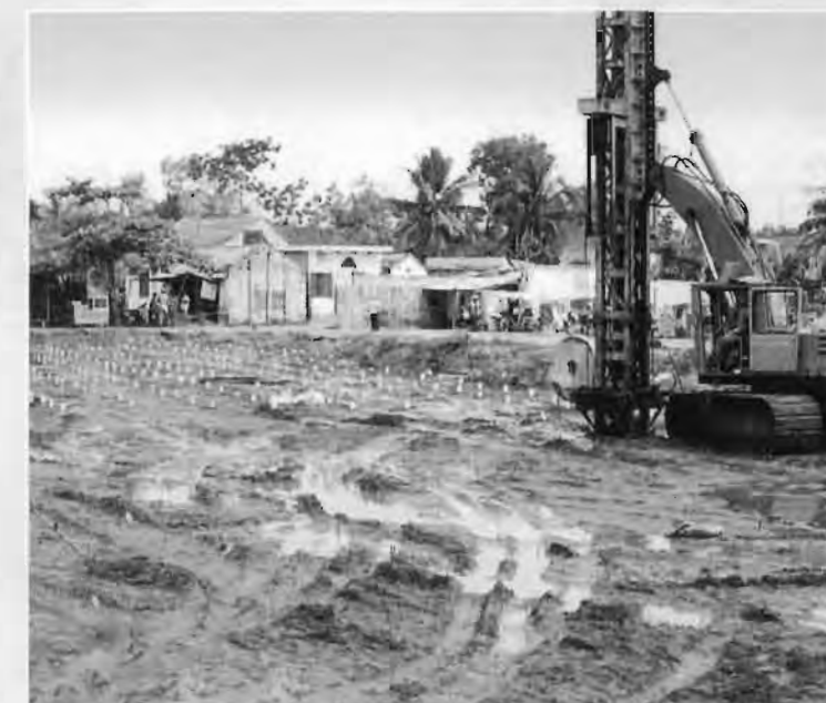
Thi công nền móng theo phương pháp chống thấm. Foundation work by draining method.
