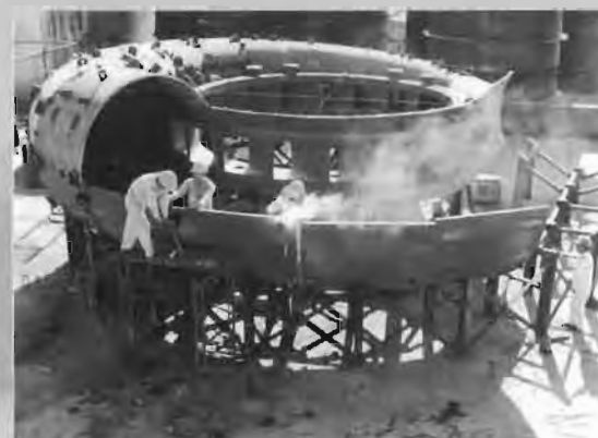
Lắp Tuốcbin nhà máy thủy điện. Turbine Installation of Hydropower plant.
