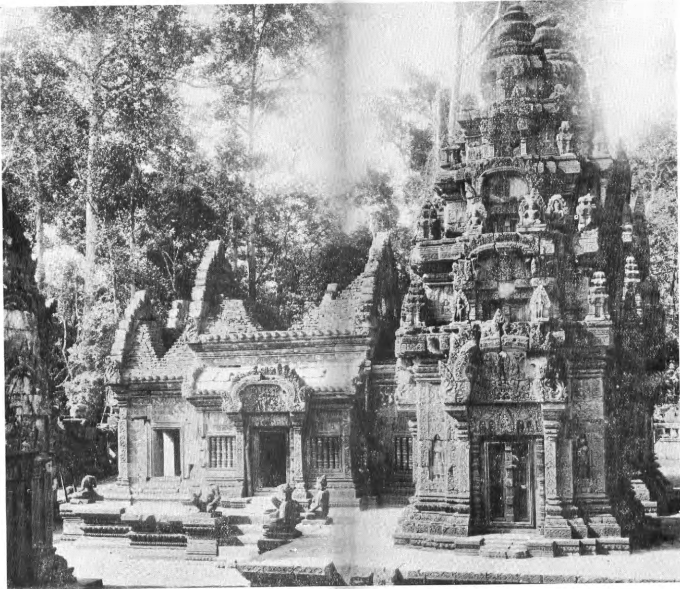
Banteay-Srey. Vue prise du Nord après restauration.
