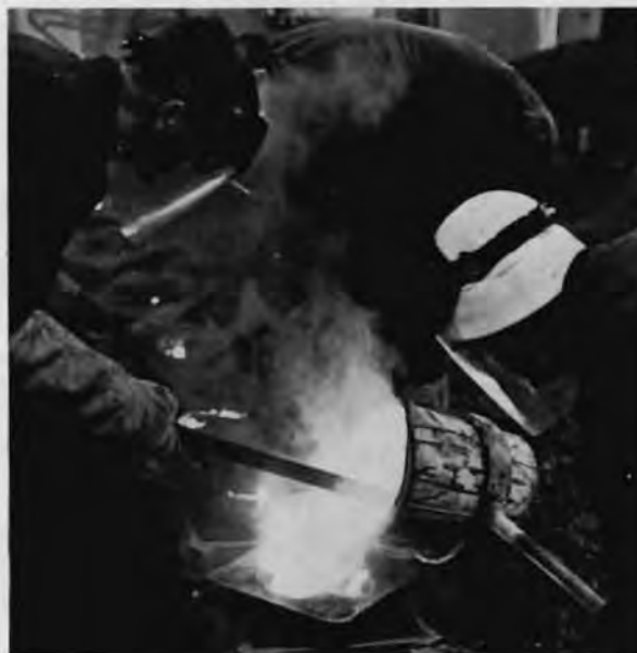
Molders pour bronze into mold.
