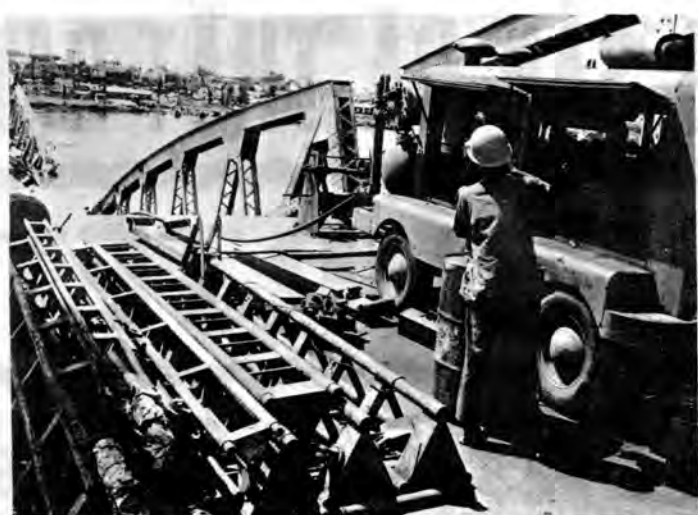
Hình trên cho thấy công cuộc trùng tu cầu Trường Tiền bị sụp đổ trong biến cố Tết Mậu Thân đang được xúc tiến.
