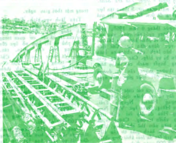
Hình trên cho thấy công cuộc trùng tu cầu Trường Tiền bị sụp đổ trong biến cố Tết Mậu Thân đang được xúc tiến.
