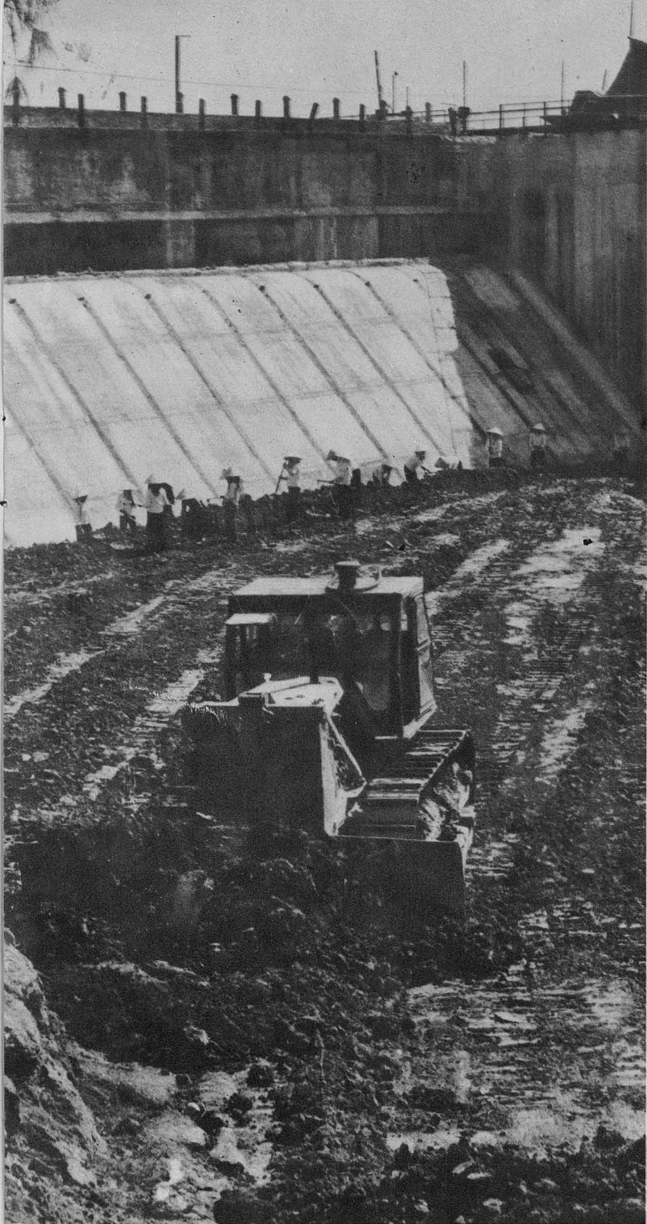
Sau một trận mưa, cái nắng càng thêm khắc nghiệt. Đội thi công cơ giới gặp không ít khó khăn trên hiện trường.
