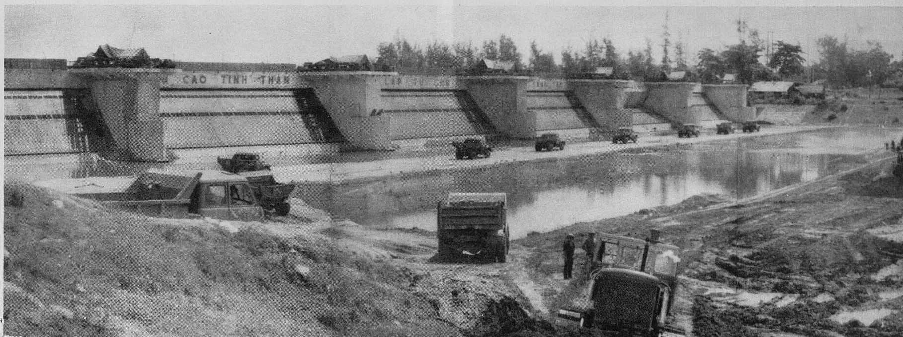
Ảnh chụp toàn công trình đập Đáy đang được hoàn chỉnh. Ở góc trái là hình ảnh còn lại của đập Đáy xây dựng thời Pháp thuộc đã bị năm tháng và lũ lụt vùi dập.
