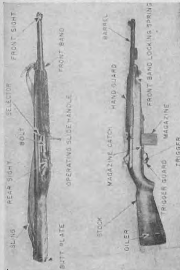
Figure 64. The U. S. carbine, caliber .30, M2.
